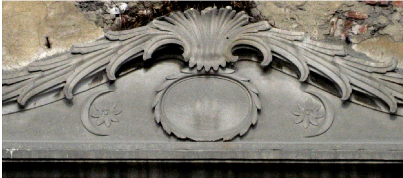
Şekil 2.4 Rami Kışlası güneybatı kanadındaki giriş kapısındaki tuğralı madalyon (17 Eylül 2008)
