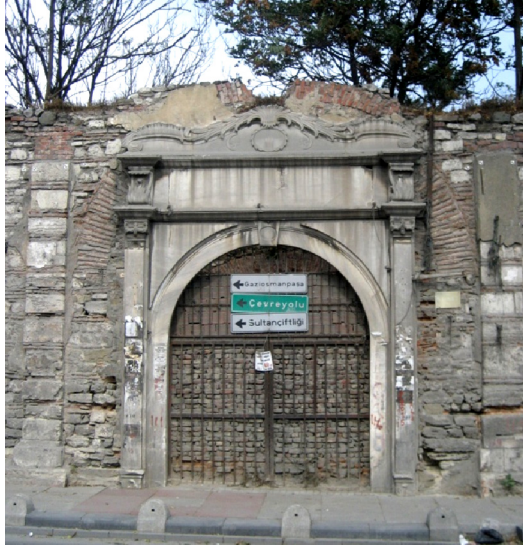
Şekil 2.3 Rami Kışlası güneybatı kanadındaki giriş kapısının günümüzdeki durumu (17 Eylül 2008)
