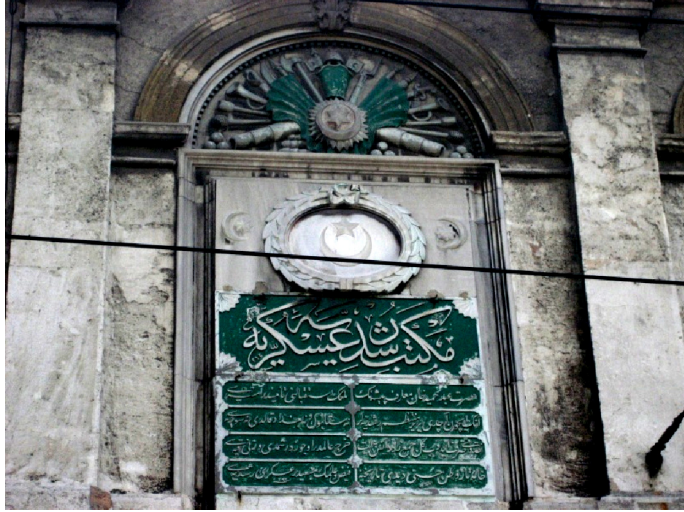
Şekil 2.11 Soğukçeşme Askeri Rüşdiyesi, kuzeydoğu cephesindeki kitabe ve madalyonu (14 Eylül 2008)
