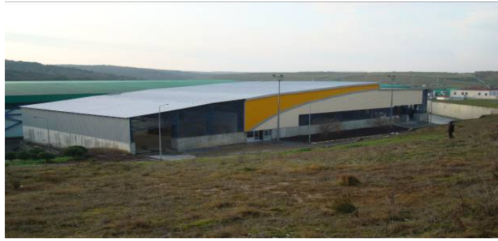
Şekil 1. RDF tesisi genel görünüm
